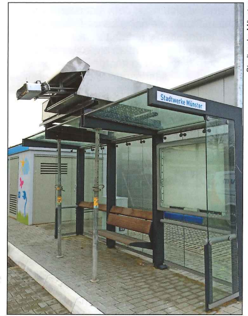
Abb. 7: Links: In den Container integrierte Leistungselektronik. Mitte: Kühlsystem für die Leistungselektronik. Rechts: Koppelarm auf dem Haltestellenhäuschen.
